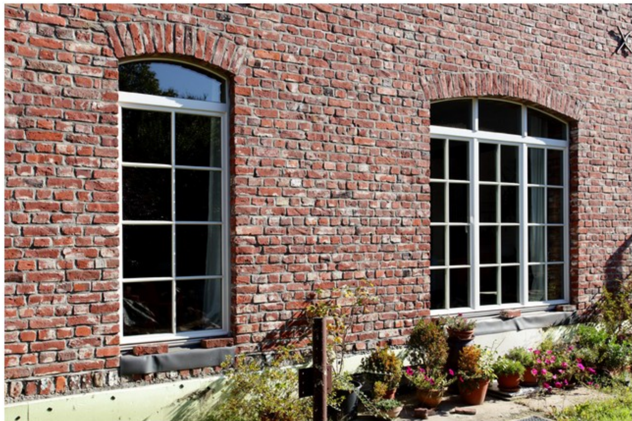
Altbausanierung: Spezielle Lösungen für die Altbausanierung eröffnen Schreinerfachbetrieben lukrative Marktchancen Foto: Frovin
